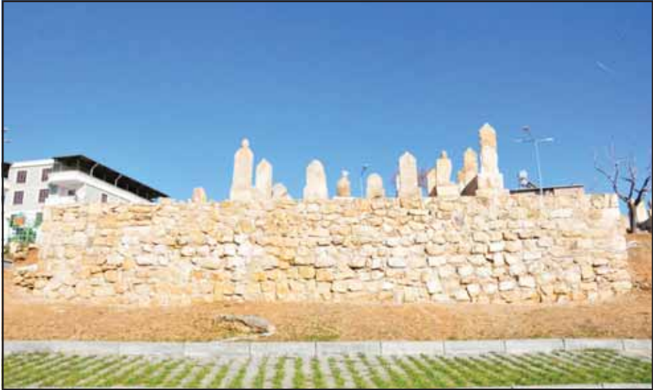
Resim 8: Mezarlıktaki orta alanın batısındaki duvarın kazı ve restorasyon sonrası durumu.
